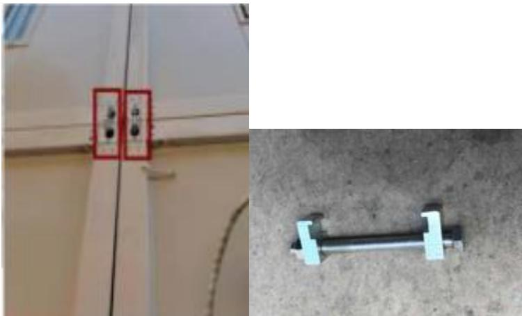
**Slika 43.** Spajanje kombiniranih jedinica, ključ za spajanje.
