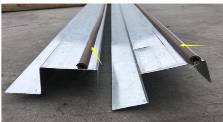
**Slika 20.** Postavljanje vodoootporne trake na U-žlijebne profile.
