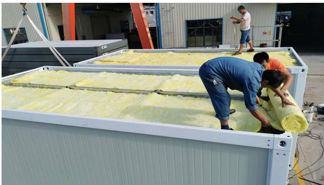
**Slika 33.** Postavljanje staklene vune za termoizolaciju.
