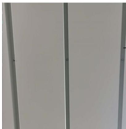
**Slika 31.** Učvršćivanje stropnih ploča čavlima.
