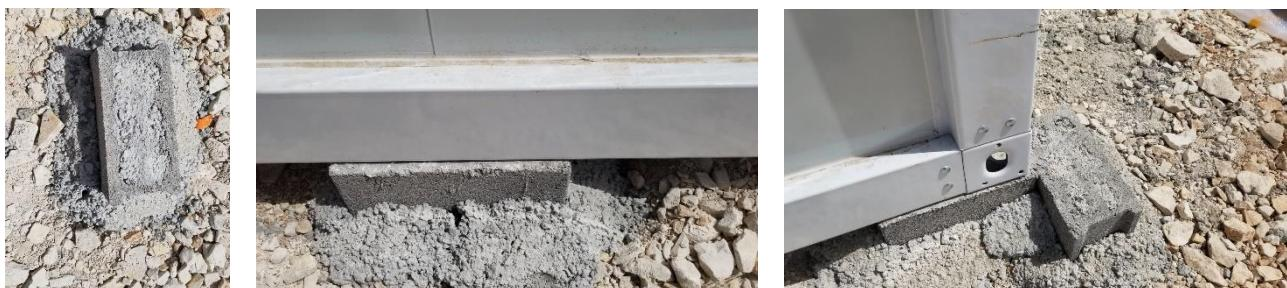
**Slika 2.** Temelj od betonskih blokova ispunjenih cementom.
