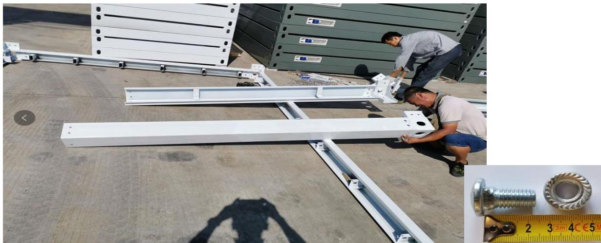
**Slika 11.** Spajanje vertikalnih kutnih nosača sa kutnim spojevima.
