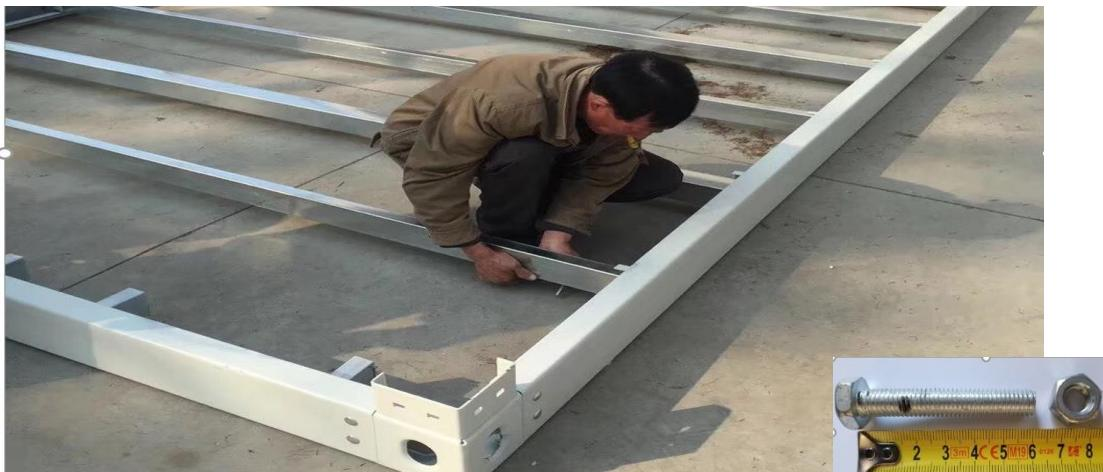
**Slika 10.** Poprečne čelične grede tvore rebrastu donju konstrukciju.
